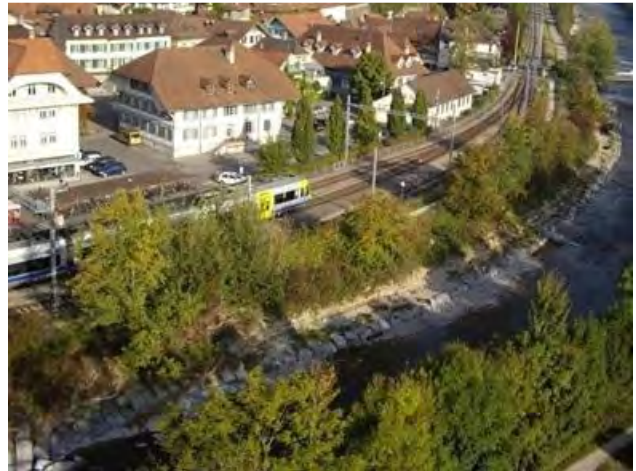
Abbildung 4.4 Uferverbau im Siedlungsgebiet von Laupen
