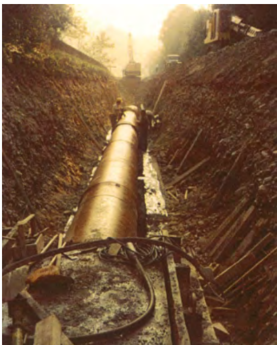
Abbildung 7.13 Bau Kanalisation von 1976 Quelle: Archiv ARA Sensetal
