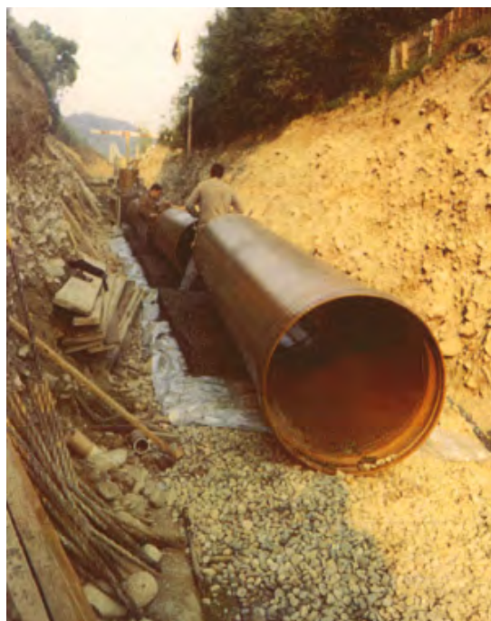
Abbildung 7.14 Bau Kanalisation von 1976 Quelle: Archiv ARA Sensetal
